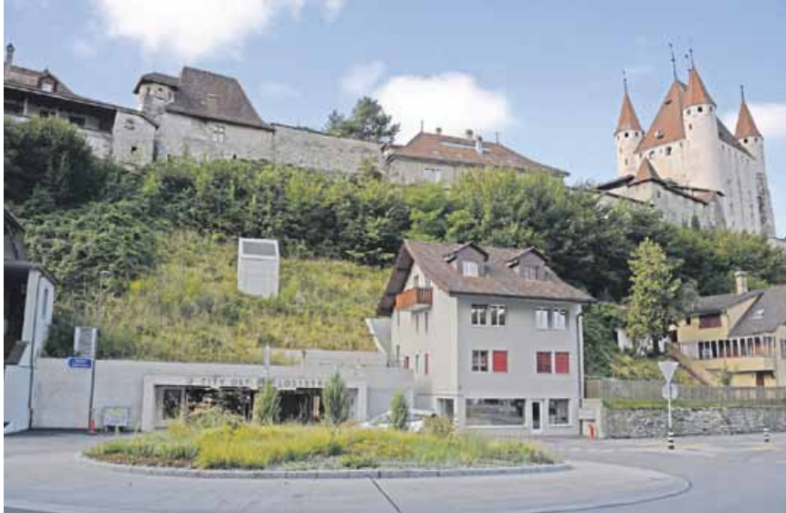
Die Anlage befindet sich im Innern des Thuner Wahrzeichens, auf dessen Gipfel das im Jahr 1109 erbaute Schloss thront.
