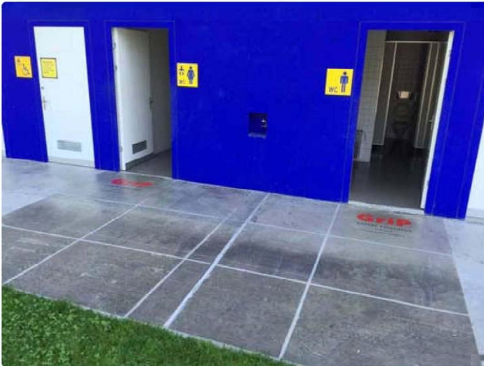
Glitschige Betonflächen jetzt für Alt und Jung sicher
