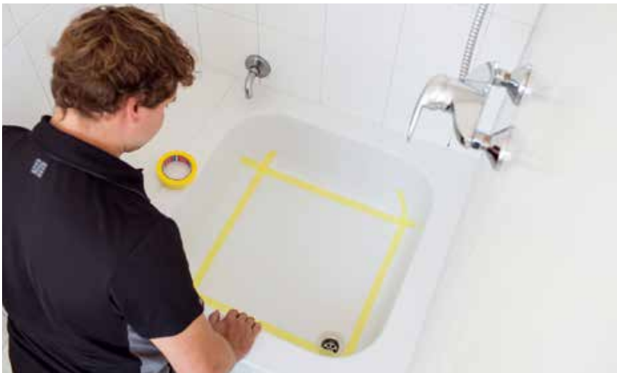
! Abkleben: Nach der gründlichen Vorreinigung wird mit dem beiliegenden Klebeband oder einem eigenen Maler-Krepp abgeklebt.
