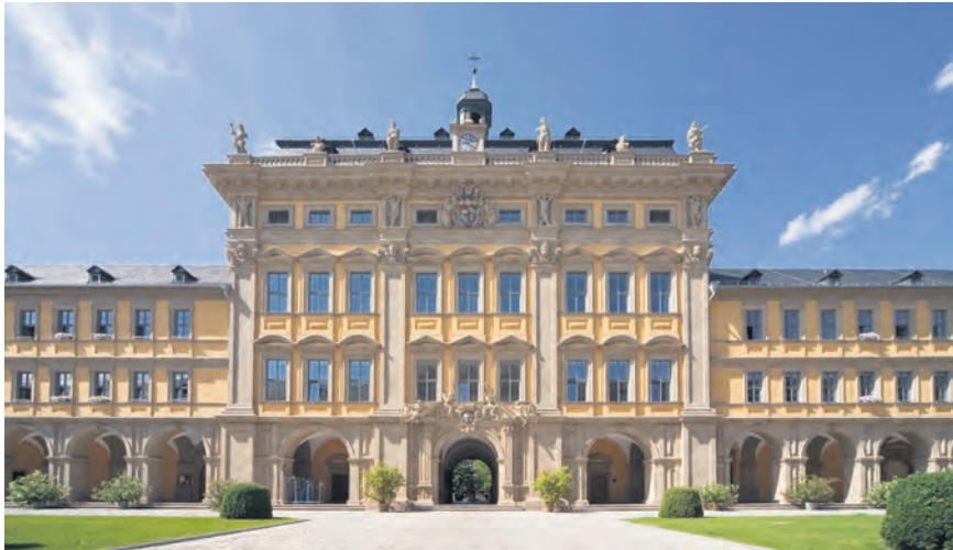
Das Klinikum im Fürstenbau, hier die frontale Ansicht.
