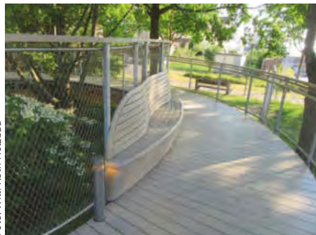
Foto: Willi Roth Holzbau
