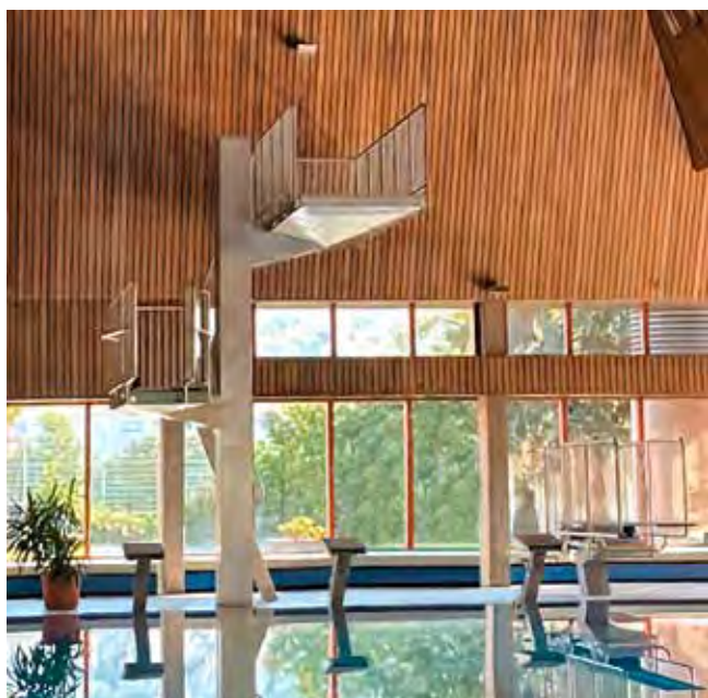
Sprungturm mit Antirutsch-Beschichtung
