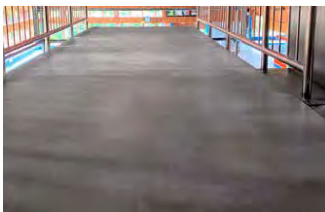
Sprungturm mit Antirutsch-Beschichtung
