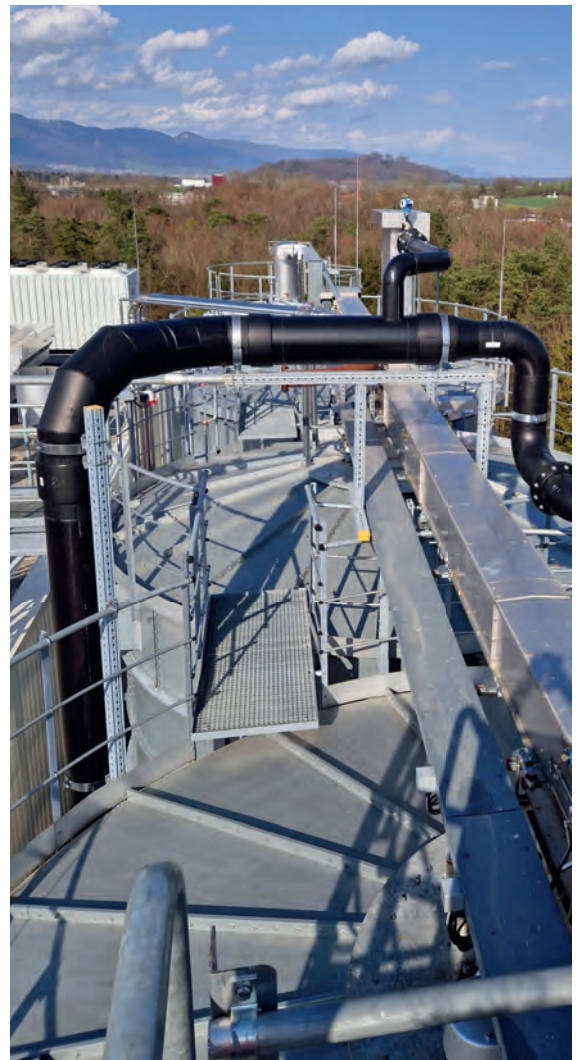
Das verwendete Produkt ist in unterschiedlichen Rutschsicherheitsklassen für den privaten und kommerziellen Einsatz erhältlich. Im Barfuß- bzw. Nassbereich besitzt das Produkt die höchste Rutschsicherheitsklasse (GB2 / C) und im Schuhbereich R11 und R12.
