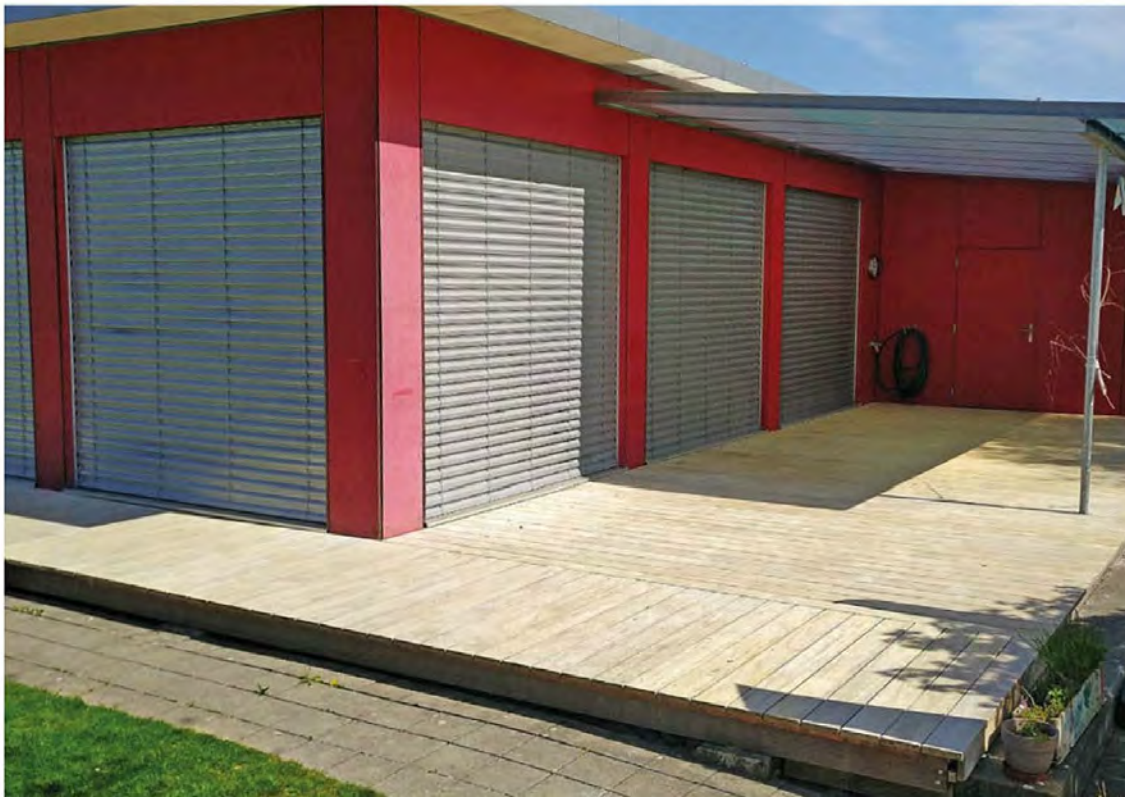
Rutschsicher gemacht: die Holzterrasse eines Kindergartens im schweizerischen Worb.
