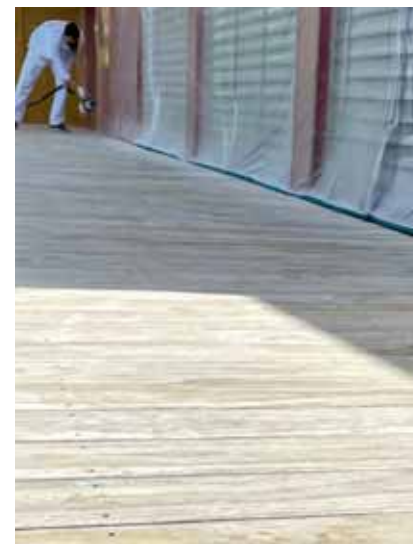
Aufbringen der körnigen Zwei-Komponenten-Beschichtung
