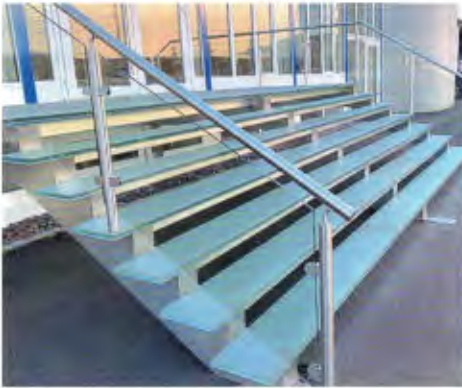
Pulsario skizzierte den Treppenaufgang selbst und beauftragte einen Stahlbauer.
