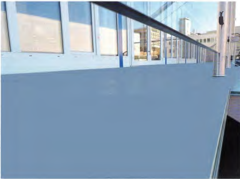
Grip Safety Coatings beschichtete die Glastreppe.
