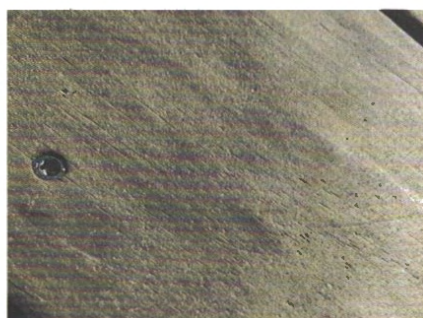
Eine körnige Beschichtung sorgt für den Antirutscheffekt.
