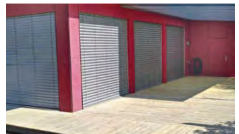
/ Auch eine Kita-Terrasse aus Accoya konnte mithilfe von SwissGrip rutschfest gemacht werden.
