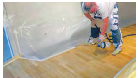
/ In 30 Minuten wird die Beschichtung aufgebracht, nach zwölf Stunden ist die Fläche benutzungsbereit.
