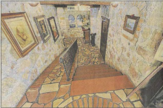
Die Antirutschbeschichtung SWISSGrip wurde direkt vor Ort mit einem Spritzverfahren auf die geflieste Rollstuhlrampe appliziert. FOTO: IL FARO
