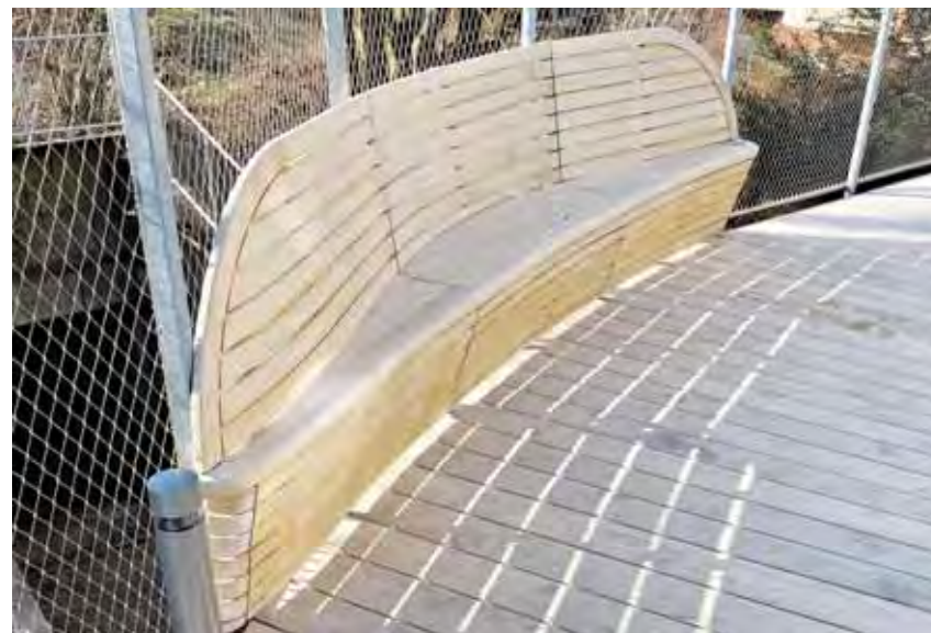
Bänke und Untergrund wurden unterschiedlich behandelt. Die Farbe des Holzes bleibt durch die Beschichtung erhalten. Foto: Swiss-Grip
